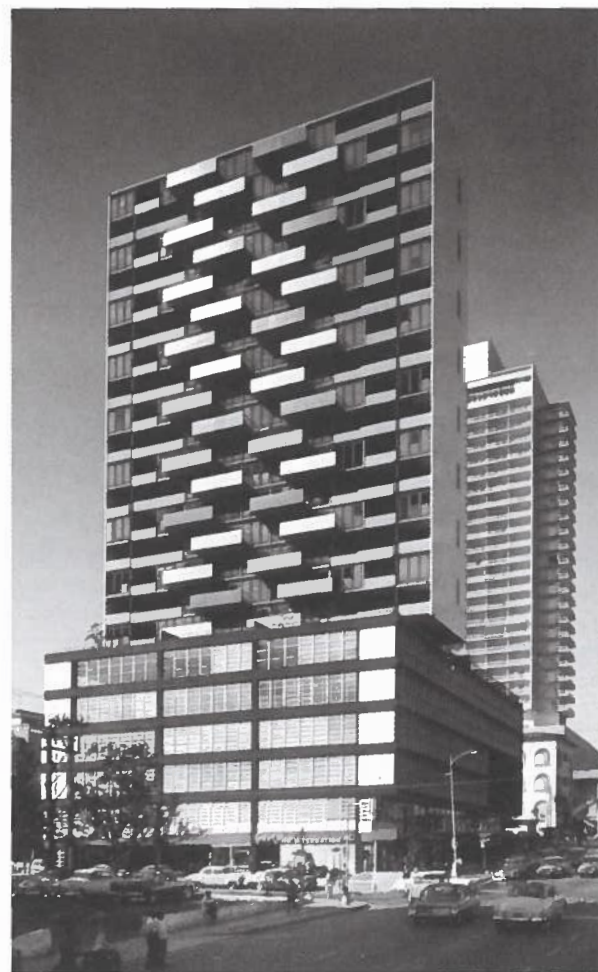
Fig. 12. Antonio Quintana assurance médicale, La Havane, 1956-1958. Le soubassement des bureaux est protégé par des brise-soleils sur la façade ouest. Le fort chromatisme, rouge et violet, et le dynamisme de la disposition des balcons rythme la composition de la tour d'appartements
