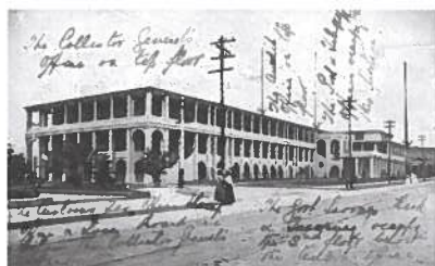
Fig. 2. Édifices gouvernementaux, King Street
