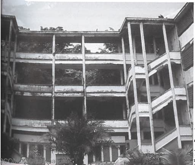
Fig. 4. Coursives et escaliers du lycée Schœlcher
