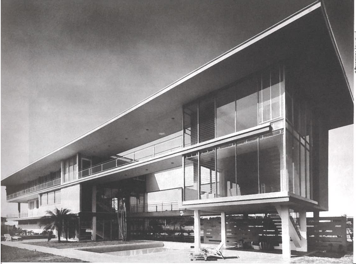
Fig. 2. Mario Romañach , maison Noval Cueto , La Havane, 1948-1949. La forme s'apparentant à l'avant-garde internationale acquiert une dimension dramatique avec les larges auvents et le patio traditionnel réinterprété de façon moderne
