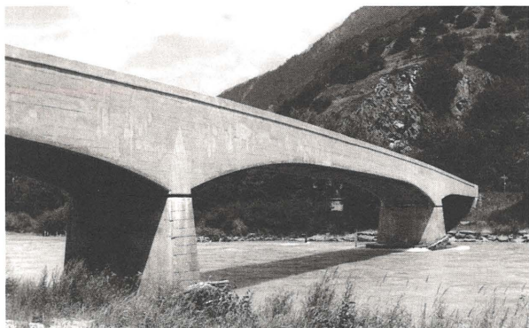
Alexandre Sarrasin's bridge, Dorénaz, 1933
