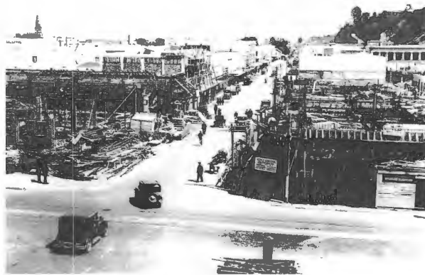
Fig. 1. Em Street rebuilding, 1933
