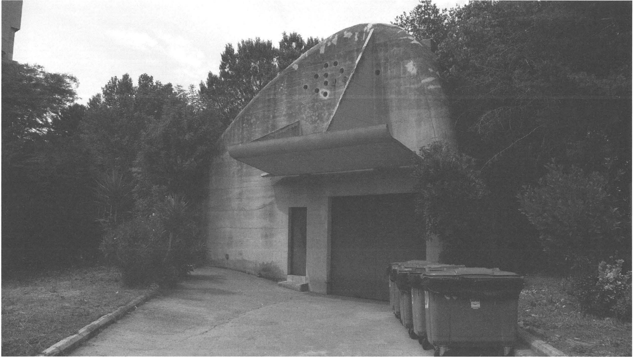
Fig. 8. Le Corbusier , Unité d'habitation dite Cité radieuse , Marseille (France), 1947-1952. Pavillon de gestion des déchets : vue d'ensemble L'Unité d'habitation, dans son extrême sophistication, comprenait dès l'origine un système de gestion des déchets provenant des broyeurs des éviers et des vide-ordures. Le pavillon situé aux abords immédiats de l'édifice principal est un commun d'une très grande qualité plastique, mais aussi d'un grand intérêt technique du point de vue de l'archéologie domestique et de la gestion des déchets : un système de transport par effet de chasse périodique, puis séparation des liquides et des solides, et enfin renvoi soit vers les égouts soit vers les bennes à ordures. Question semble-t-il triviale mais aujourd'hui loin d'être secondaire, car elle affronte la compatibilité technique, la conservation et la restauration, et la mise aux normes contemporaines. S'il est assez aisé de prescrire les éléments à conserver et à restaurer dans un bâti afin d'assurer la pérennité d'une forme, jusqu'à quel point peut-on maintenir des usages, dans un contexte de normalisation d'équipements collectifs qui dépasse la sphère de la copropriété et relève de la gestion publique ?
