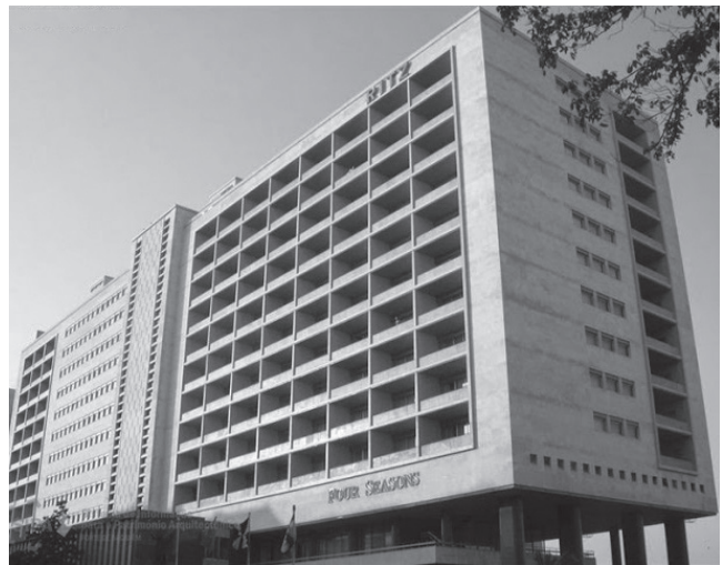
06 Porfírio Pardal Monteiro, Ritz Hotel, Lisbon, Portugal, 1956. © SIPA archive.
