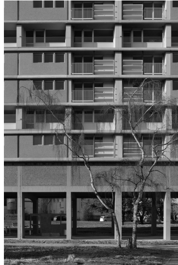
02 Willy Van Der Meeren, Ieder Zijn Huis , Brussels, Belgium, 1953-1961. Detail of the East façade during renovation. © ORIGIN, Georges De Kinder.
