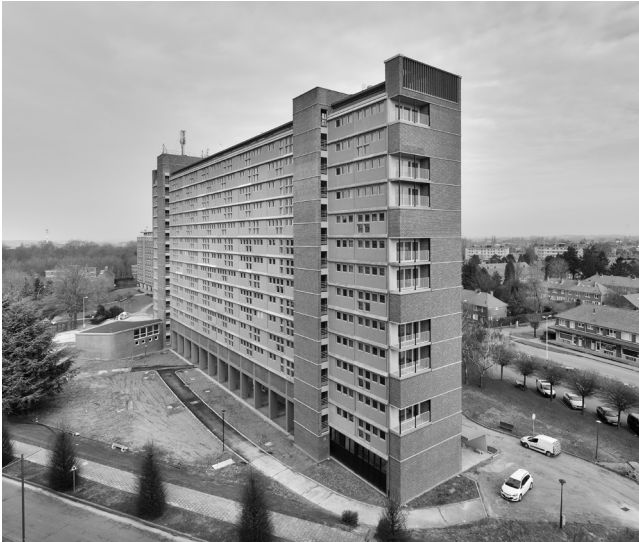
01 Willy Van Der Meeren, Ieder Zijn Huis , Brussels, Belgium, 1953-1961. West and North façades after renovation. © ORIGIN, Georges De Kinder.
