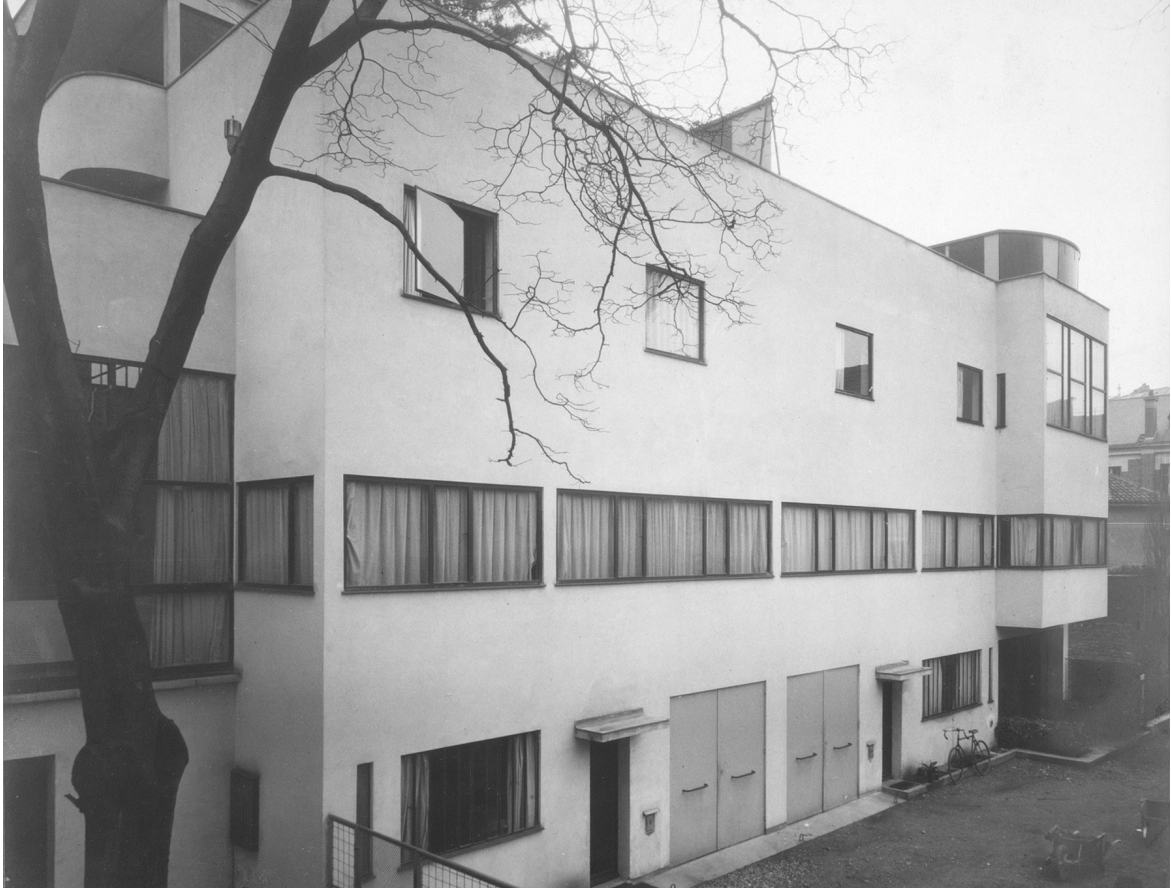
01 Le Corbusier and Pierre Jeanneret, Maison La Roche , Paris, France, 1925. © FLC/SPA, 1926.
