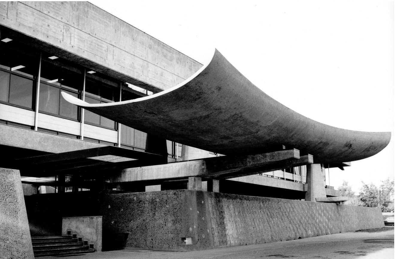
07 Emilio Duhart, ECLAC building, Santiago, Chile, 1966. Main entrance canopy. © Emilio Duhart Archives. Archivo de Originales, Centro de Información y Documentación Sergio Larraín García-Moreno. Facultad de Arquitectura, Diseño y Estudios Urbanos. Pontificia Universidad Católica de Chile.
